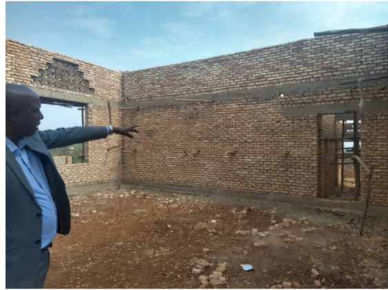
De nieuwe grote zaal in aanbouw voor de presbyterie
